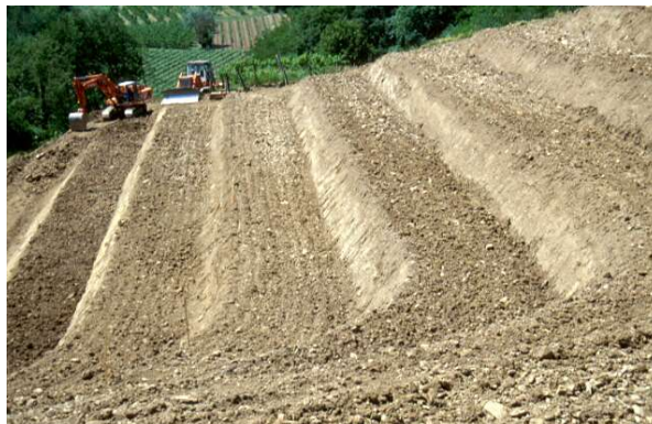
Slika 9: Prekopavanje teras z bagrom – avtor Andreja Škvarč
