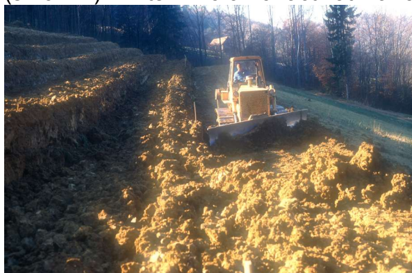
Slika 10: Izdelava teras ali obdelovalnih poti na točno določeno širino terasne ploskve z buldožerjem
